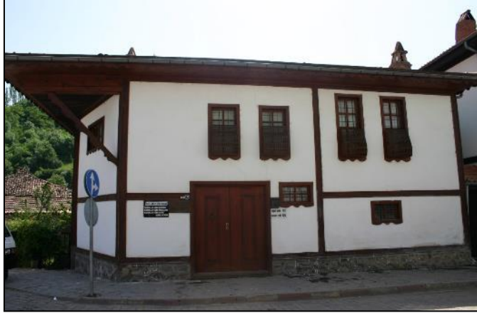
Fotoğraf 8: Yapının Sokak Cephesi
