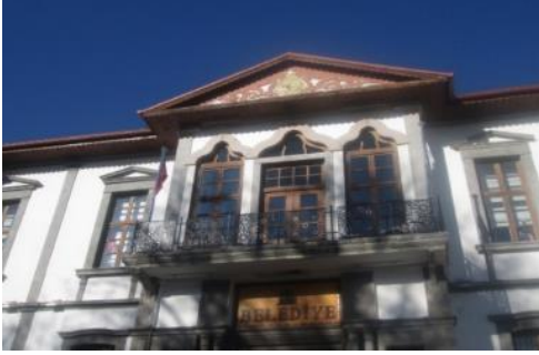
Hükümet Konağı Balkonu
