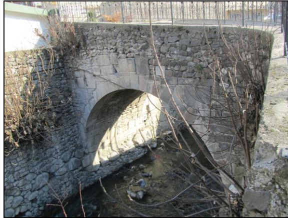
Fotoğraf 94: Çilhane Köprüsü
