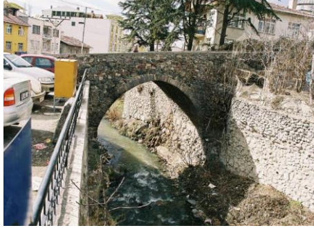
Fotoğraf 35: Seymenler Köprüsü
