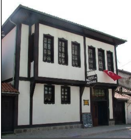
Fotoğraf 7: Yapının Sokak Cephesi
