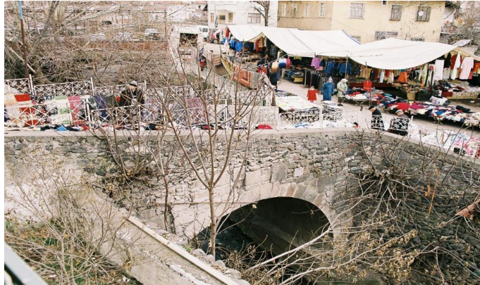
Fotoğraf 34: Çilhane Köprüsü
